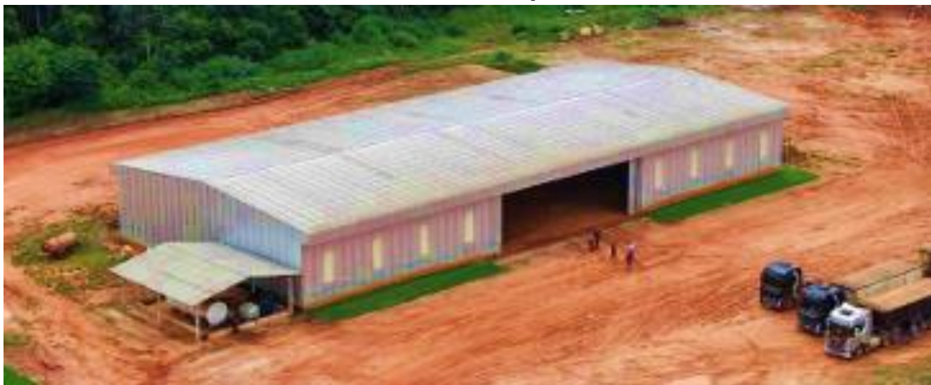
BARRACÃO DE MÁQUINAS
