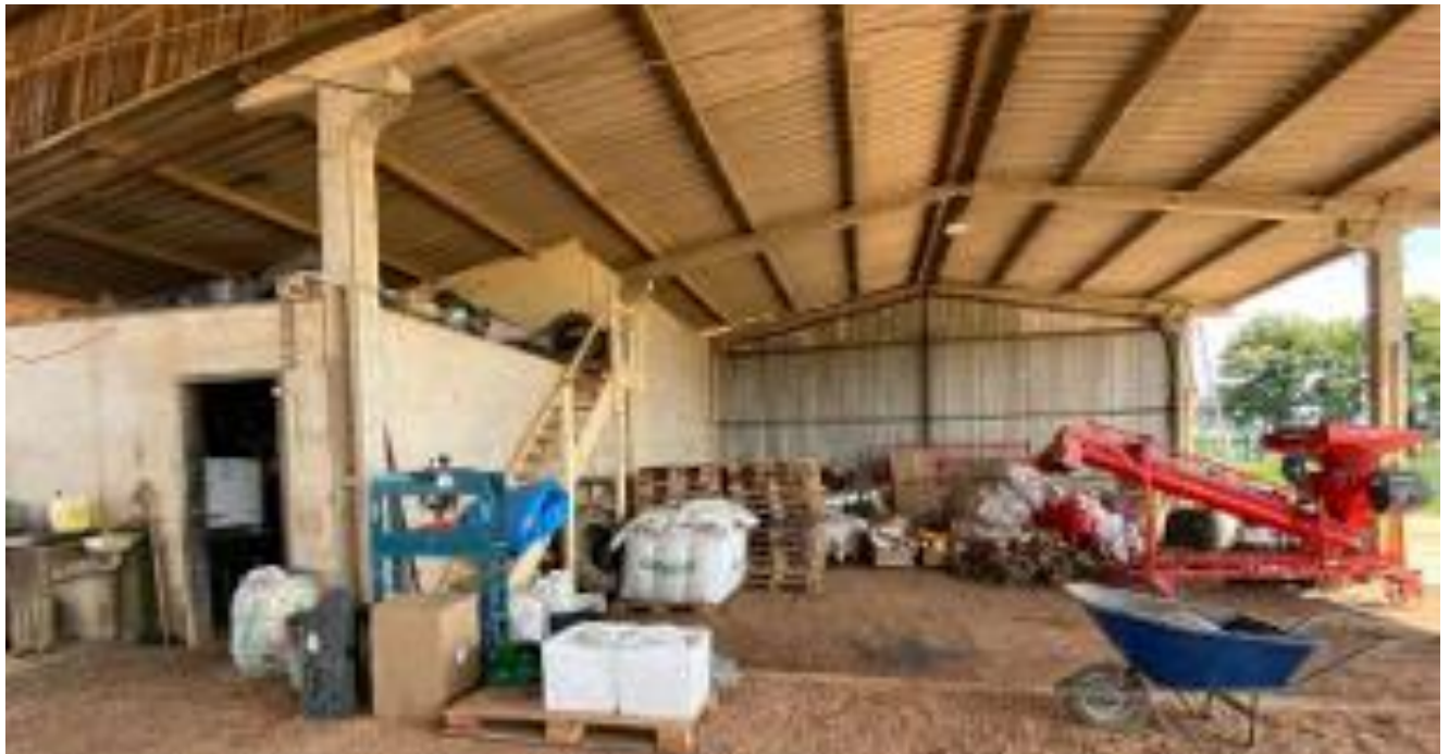
BARRACÃO DE MÁQUINAS – INTERNO
