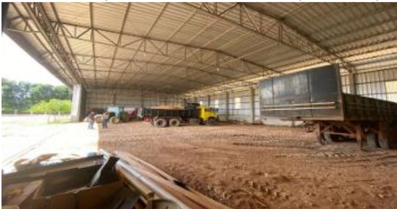
BARRACÃO DE MÁQUINAS FECHADO INTERNO FAZENDA ÁGUA VIVA (SEDE SINOP-MT)
