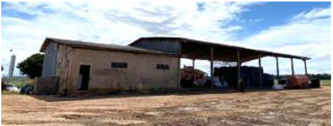
GALPÃO DE ADUBOS E DEFENSIVOS
