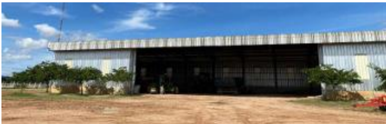
BARRACÃO DE MÁQUINAS FECHADO - FAZENDA ÁGUA VIVA (SEDE SINOP-MT)
