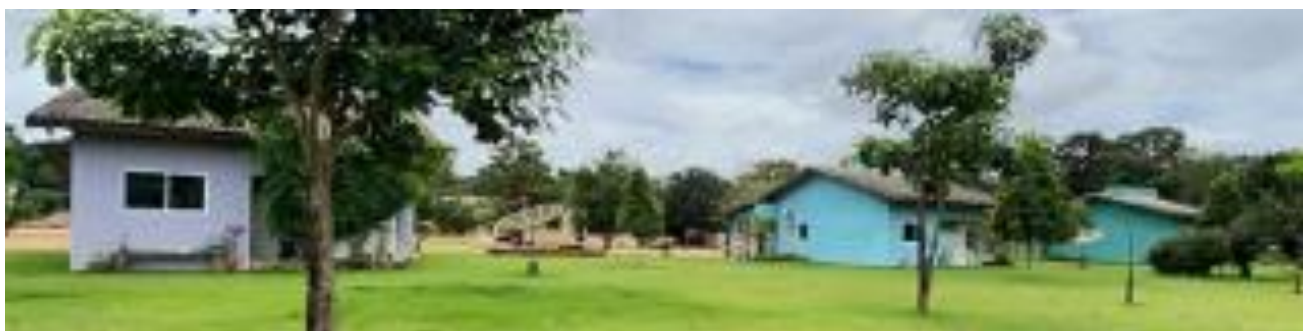
CASA SEDE 1-2-3 EM ALVENARIA FAZENDA DOIS RIOS (SEDE UNIÃO DO SUL-MT)
