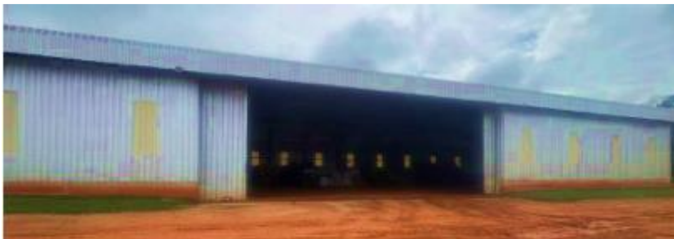
BARRACÃO DE MÁQUINAS
