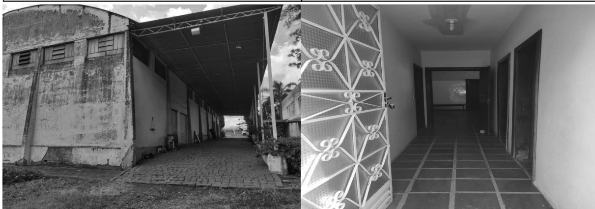
Foto da parte externa do galpão
