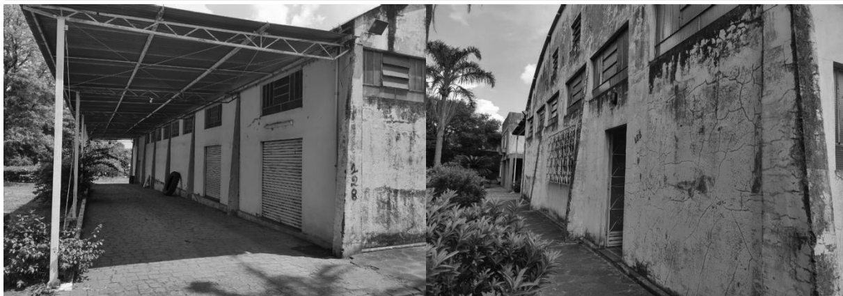
Foto da parte externa do galpão
