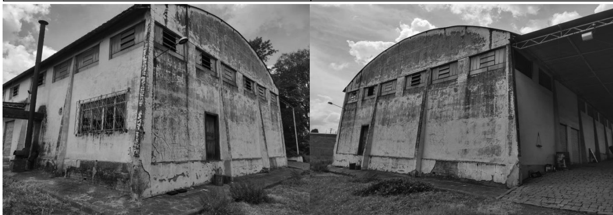
Foto da parte externa do galpão
